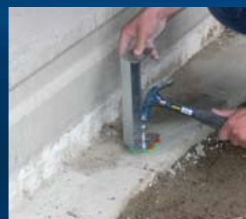
aanbrengen bevestigingsmiddelen
