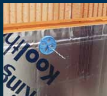
indraaien UNI-Bouwsouwanker m.b.v. Indraaihulpstuk
